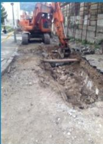
Početak iskopa, Teljeva ulica
