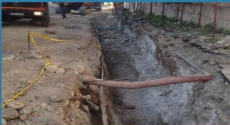
Iskop kanala za oborinski cjevovod
